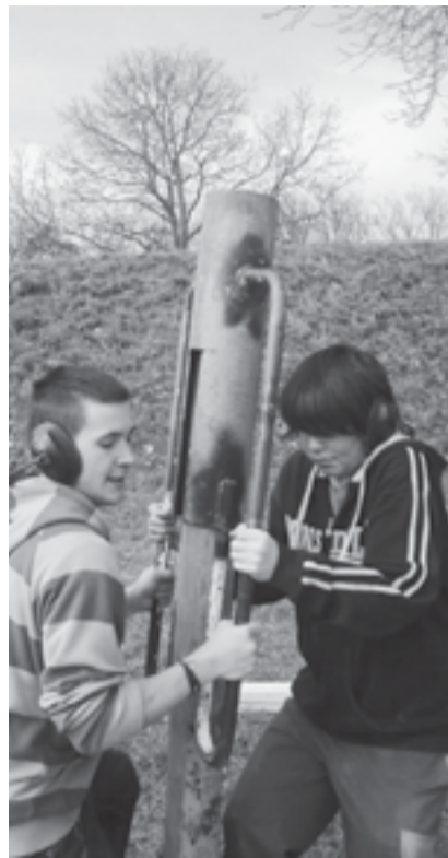
Mit der Rammkatze beim Erstellen eines Pferdezauns. (Bild B. Homberger)
