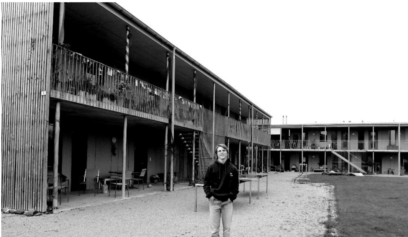
Weiler Zum Pflug: Sandro Müller wohnt im neuen Wohnhaus Sozialtherapie. Im Hintergrund das Wohnhaus Landwirtschaft.
