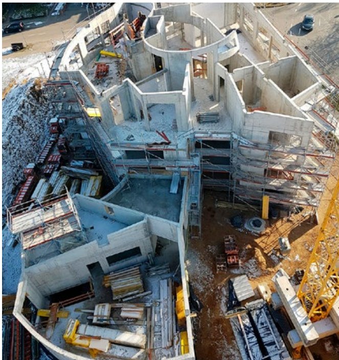
Mit Pneumatit gebaut – Schulgebäude in Karlsruhe
